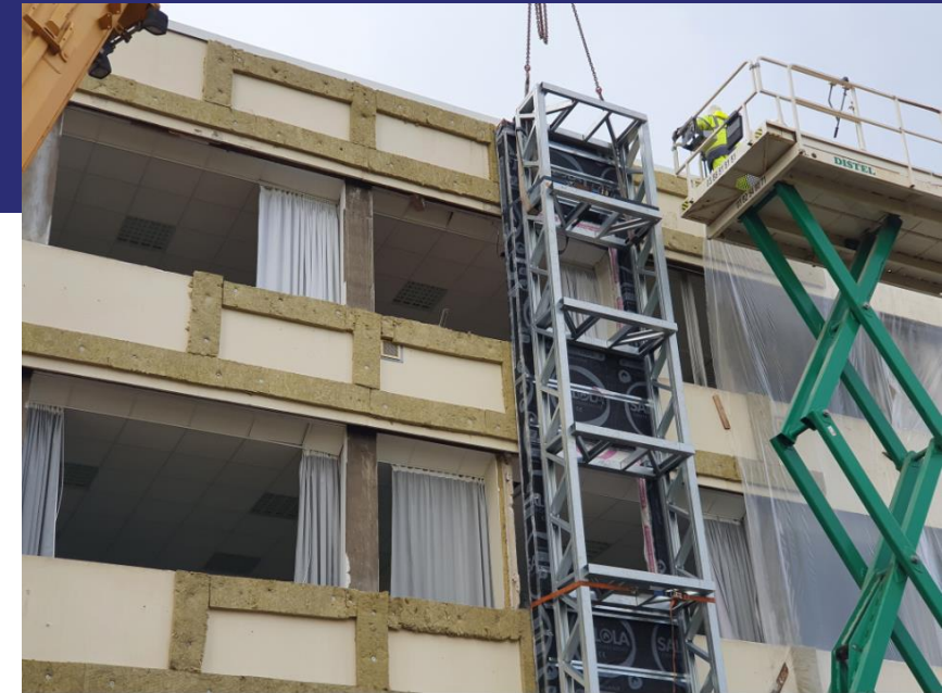
Travaux sur les façades du lycée Schuman à Metz
